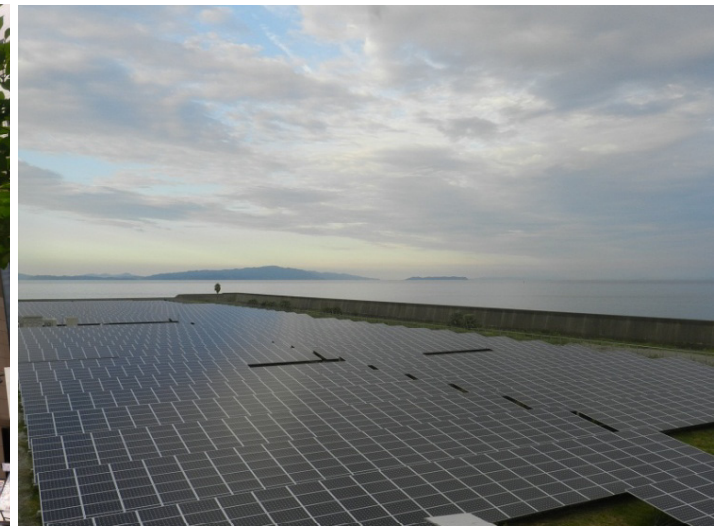
いちごECO徳島東沖洲発電所(メガソーラー)
