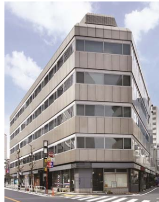
■ 大井町センタービル
