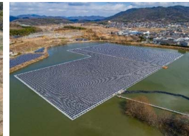
いちご笠岡岩野池 ECO発電所
