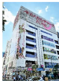
AKIBAカルチャーズZONE
