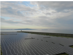
いちごECO徳島東沖洲発電所
