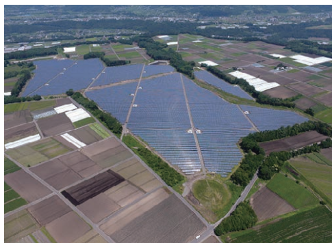
いちご昭和村生越ECO発電所(関東最大)
