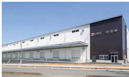
いちご東松山物流センター (埼玉県東松山市)
