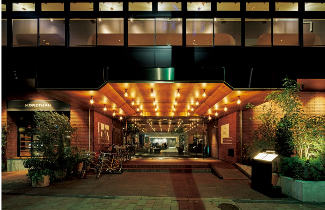
ホテルエントランス。軒裏にはチーク材突き板を貼った
