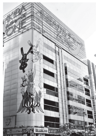
▲「AKIBAカルチャーズZONE」
