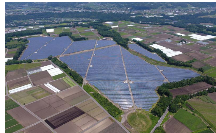
昭和村生越ECO発電所
