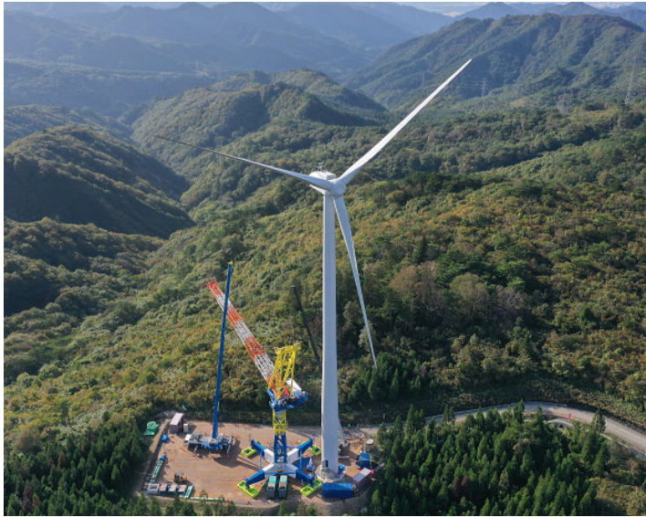
■ 風力発電機の組み立て風景
