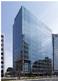
いちご花京院ビル
