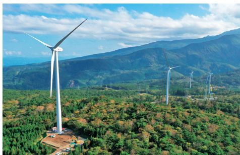
「いちご米沢板谷ECO発電所」
