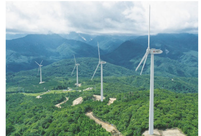
■ いちご米沢板谷ECO発電所
