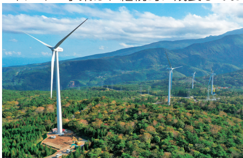
「いちご米沢板谷ECO発電所」
