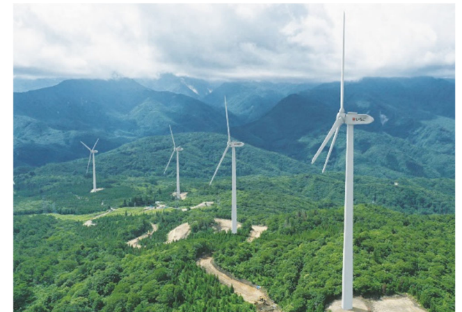
■ いちご米沢板谷ECO発電所
