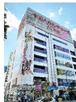
AKIBAカルチャーズZONE
