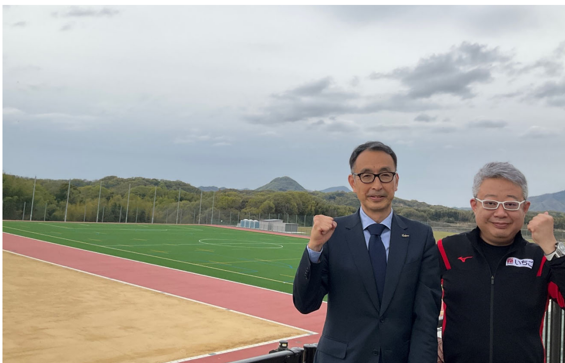
建設中の宝山湖ボールパーク
