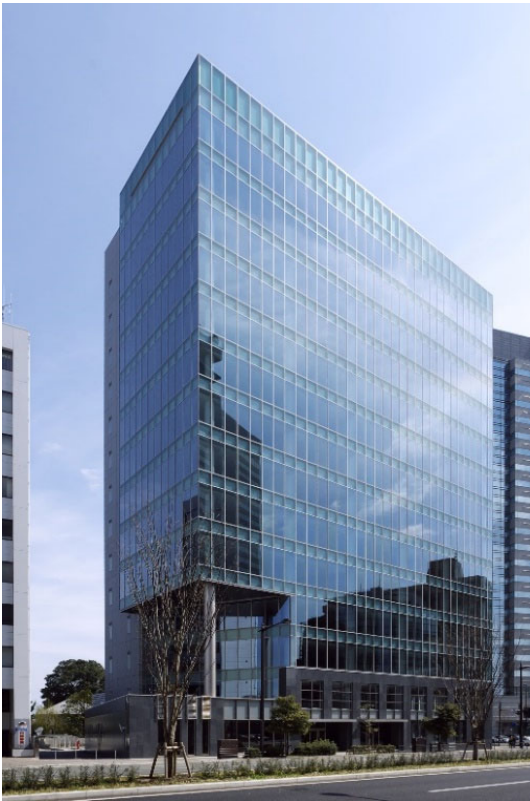
■ いちご花京院ビル(宮城県仙台市)
