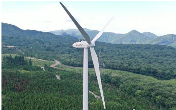
いちご米沢板谷ECO発電所
