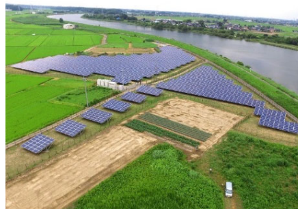
いちご取手下高井北ECO発電所
