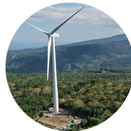
いちご米沢板谷ECO発電所
