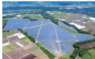
関東最大の太陽光発電所
